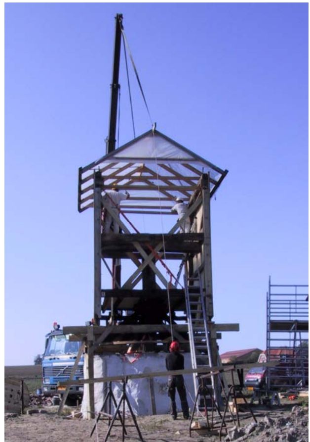
Kun siderne kom op i hele stykker med beklædning – gavlenes tømmer blev sat imellem. Alt afstivet og et midlertidigt tag oplagt.
