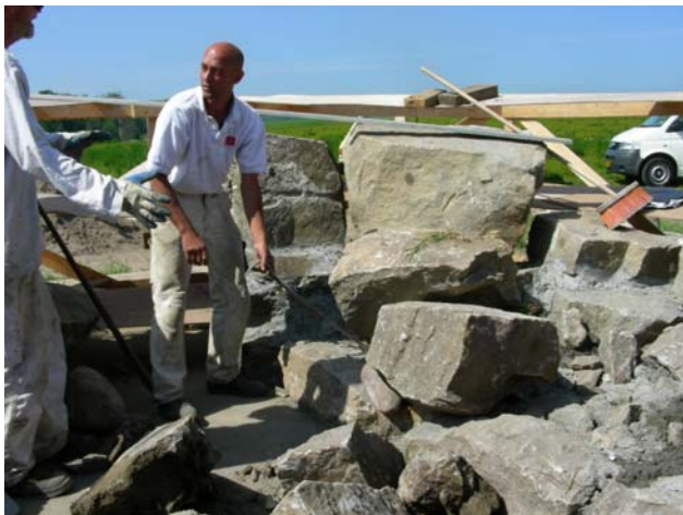
De store granitblokke bakes på plads i det store "puslespil" indenfor modellen.
