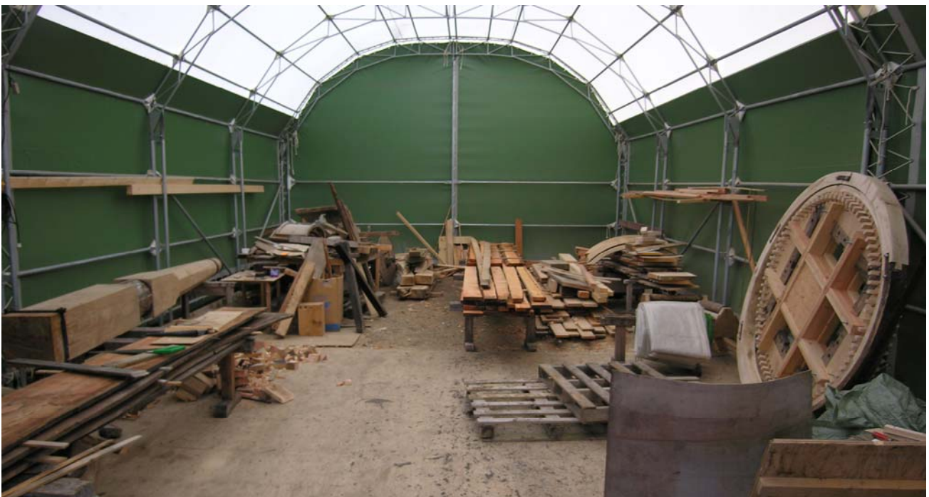
I det store telt står endnu – godt beskyttet mod vind og vejr - de nye restaurerede dele. Til venstre "åsen" (mølleakslen), til højre det store hathjul, som monteres på åsen. I baggrunden de gamle dele, som skal danne model for "kværnbesætningen" – det kar som indkapsler kværnstenene, tragt til kornet og "stige med skoslag", som leder kornet ned i kværnen. Herinde ligger også vindbrædder til vingerne – disse ligger samlet og tjæret udenfor teltet.
