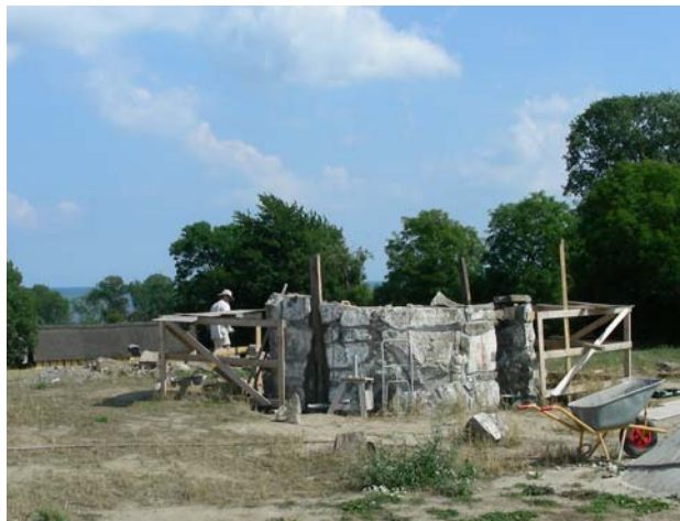
Det runde fundament tæt ved "rejsehøjde", hvor møllens trækonstruktion kan opsættes.
