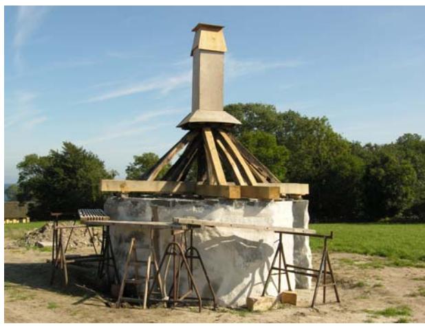
Ny krydsfod, skråstive og stub er rejst på det genskabte fundament. Herefter fulgte den nye egetræsring til støttebenene.
