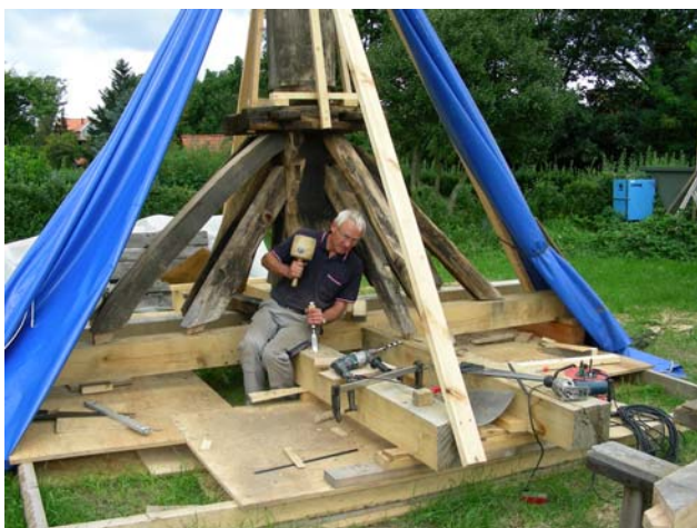
Stub og de fleste skråstive genanvendes. Her passes det gamle tømmer sammen med den nye krydsfod af fire stykker egetømmer.
