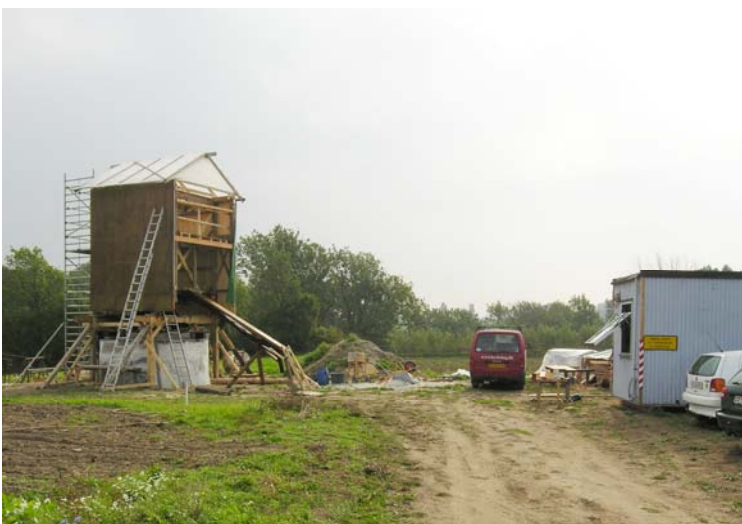
Byggepladsen med skur og containere blev flyttet fra teltet til møllen, hvor en stor del af arbejdet nu foregik. En midlertidig elforsyning blev afløst af en permanent, indbygget i møllens fundament
