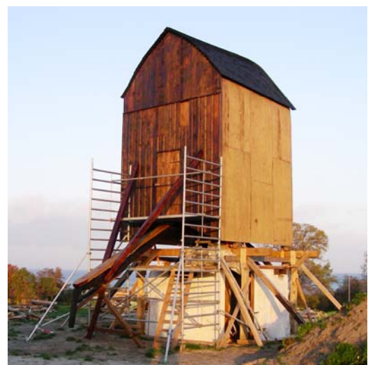
Møllen med det gamle tag – oplagt i hel tilstand - svansen med skrånstivere monteret og "lægavlen" med indgangsdøren døren til møllen.
