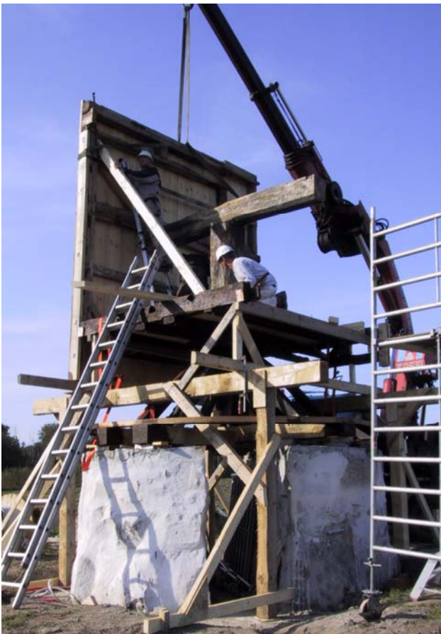
Stenbjælken ovenpå stubben lægges først og dernæst "hænges" siderne op på hver sin ende af stenbjælken, der faktisk bærer hele møllen.
